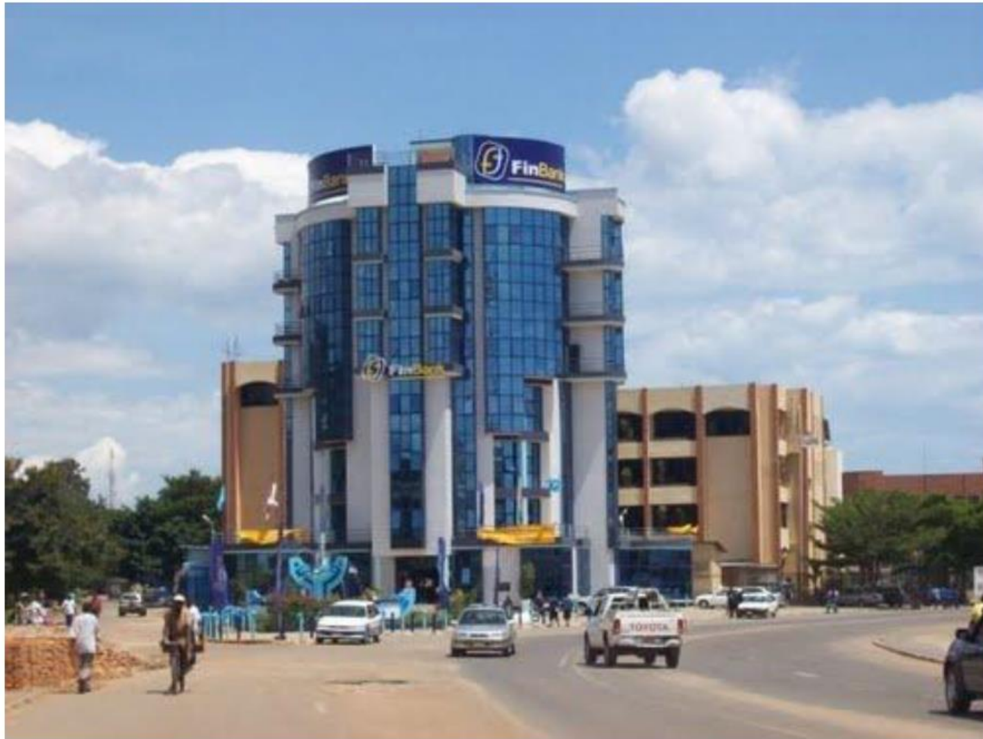
The New FinBank Burundi Headquarters, Boulevard de l'Indépendance
